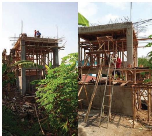
Proses Pembangunan Rumah Air Minum
