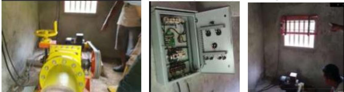
Gambar 9. Instalasi generator, kontroler dan dummy load pada rumah turbin
