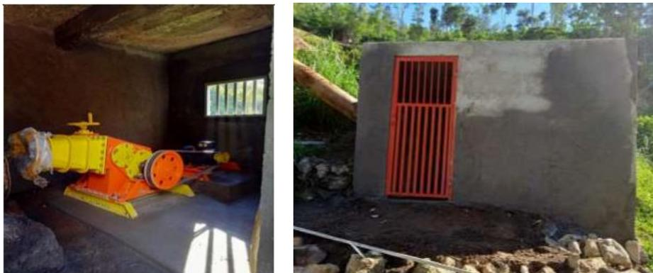
Gambar 2. Unit turbin yang telah terpasang dan rumah pembangkit yang telah direkonstruksi
