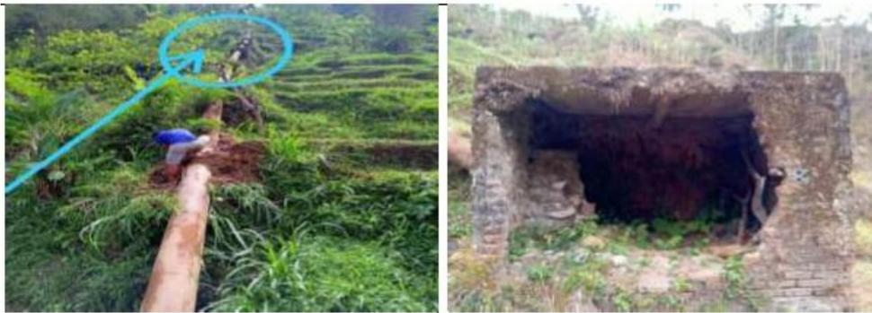
Gambar 1. Kondisi sebelum diseminasi TTG, yaitu pipa pesat yang rusak dan rumah pembangkit yang sudah lapuk
