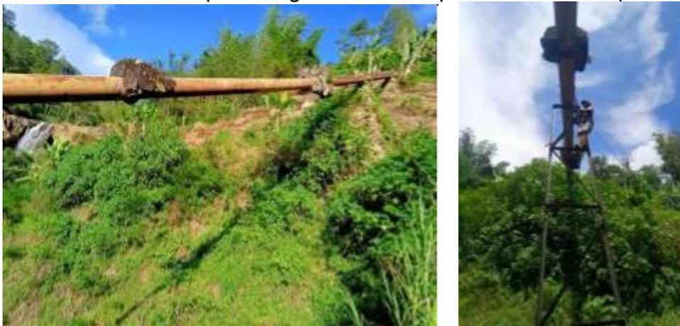
Gambar 7. Kondisi Pipa Pesat dan Pemasangan Tiang Penyangga
