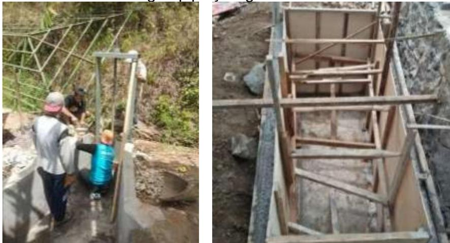
Gambar 6. Desain dan pembangunan saluran pembawa ke bak penenang
