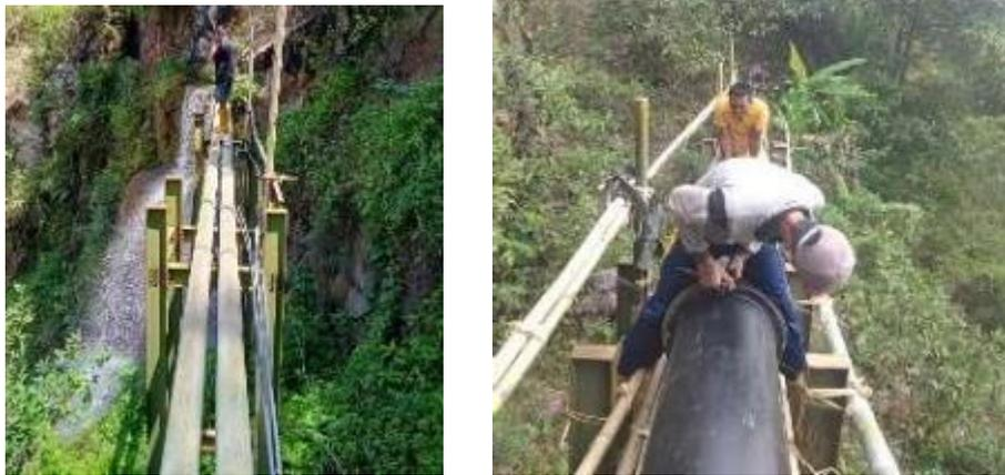
Gambar 5. Pelepasan pipa saluran irigasi lama dan penggantian pipa pembawa dengan pipa yang lebih besar
