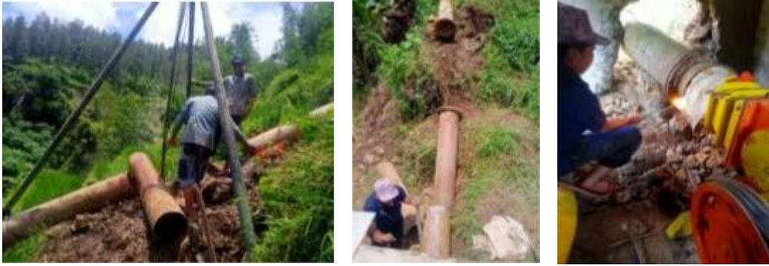
Gambar 8. Penggantian dan penyambungan pipa pesat dengan turbin air
