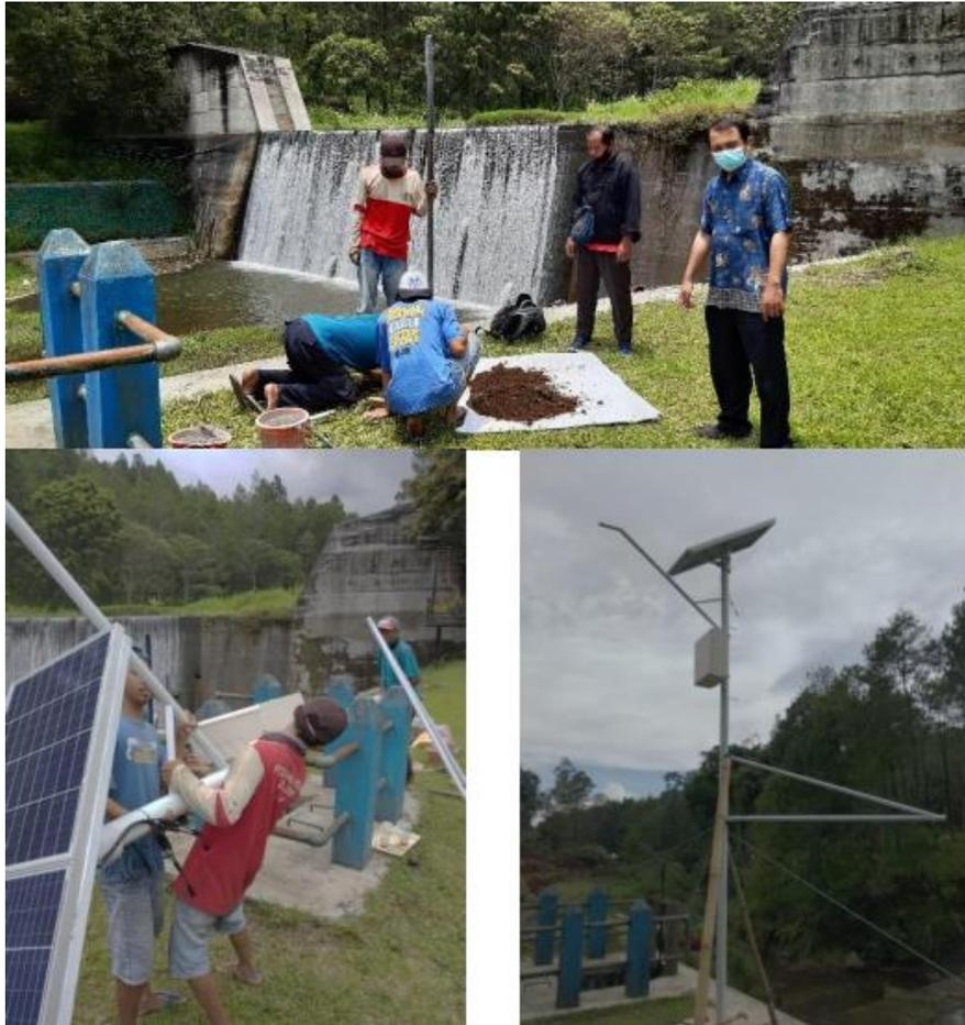
Gambar 5. Pemasangan tiang sensor ketinggian air dan lampu taman bertenaga surya di Waduk Coban Talun
